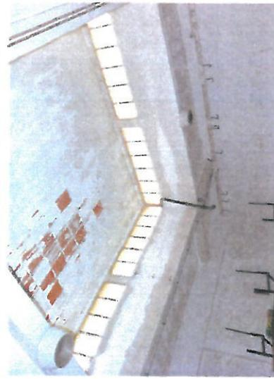
L'intérieur montre l'ossature en béton armé et les remplissages en parpaings, ainsi que l'éclairage zénithal offert par le lanternon de la toiture.
